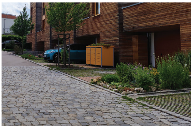
Abb.45 Entsiegelung Parkplatz, EQP, Pfaffenhofen, Ramboll Studio Dreiseitl © Jin Peng
